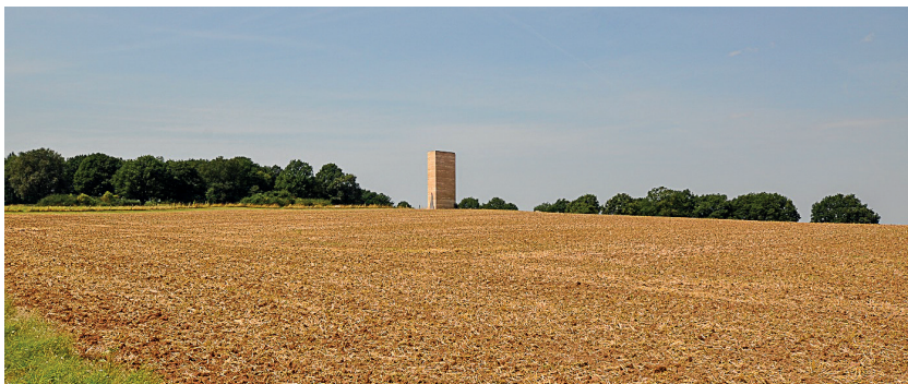
1. Kaplica Brata Klausa w Mechernich – proj. arch. P. Zumthor
